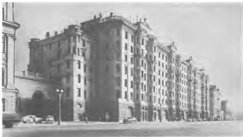
145. Ленинград. Крупнопанельный жилой дом в районе Шемловки, 1956 г. А. Васильев, З. Каплунов
