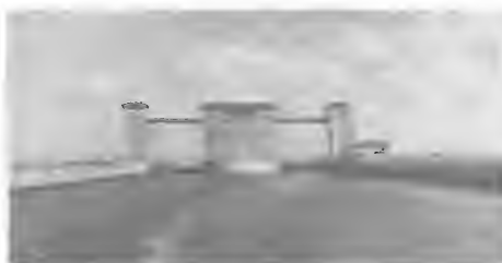
138. Угличская ГЭС Вид с верхнего бьефа
