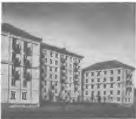
142. Москва. Застройка Хорошевского шоссе каркасно-панельными домами, 1951 г. М. Посохин, А. Мидяниц, В. Лагутенко
